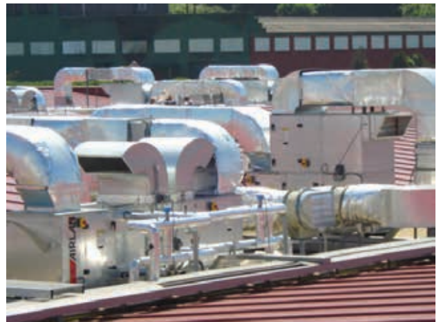
Central de Tratamiento de Aire Marca AIRLAN Serie ME
