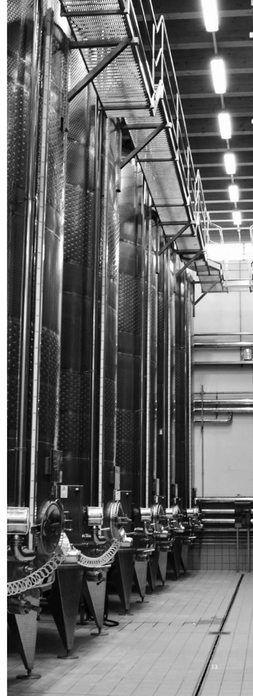
Bodega Vivallis. Tanques con camisas de intercambio térmico para controlar la temperatura.
